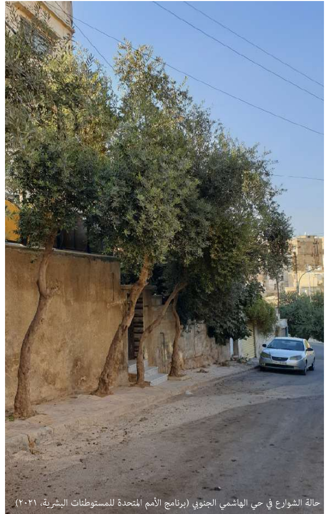
حالة الشوارع في حي الهاشمي الجنوبي (برنامج الأمم المتحدة للمستوطنات البشرية، ٢٠٢١)
